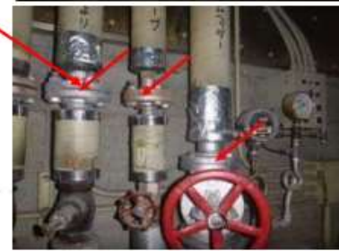
フランジ部ガスケット:12本 2箇所×(表裏)計48箇所 煙道パッキン4箇所
