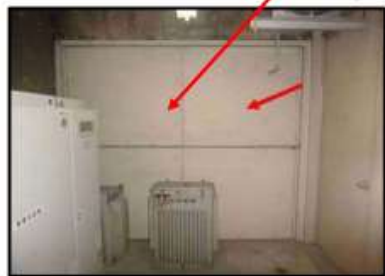
フレキシブルボード 除去面積:6.24㎡
